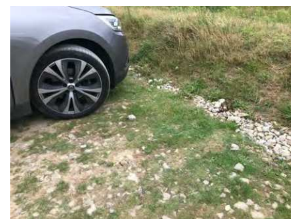
Drain en ballast en pied de talus
