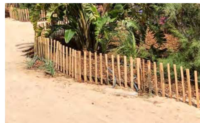
Clôture basse en ganivelle pour protection de la végétation et mise à distance
