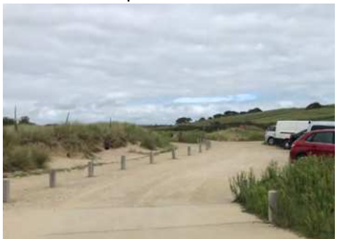
Contention en poteau bois section carrée
